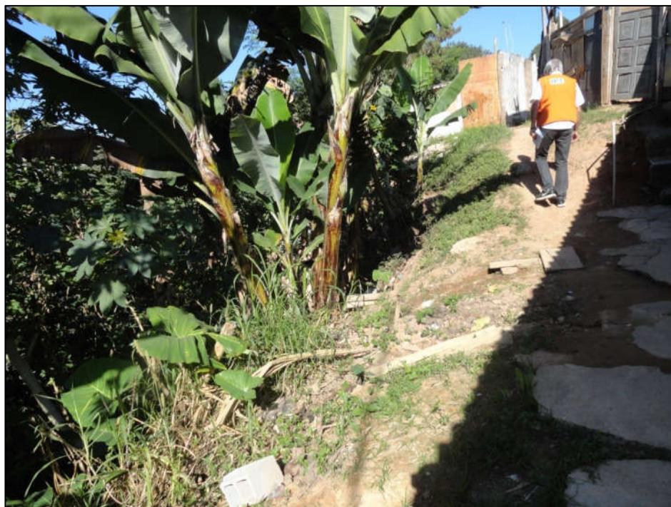
Foto FC-ITA-14-02.01: Trecho superior do setor de alto risco para escorregamentos com as moradias à direita e o talude de aterro à esquerda.
