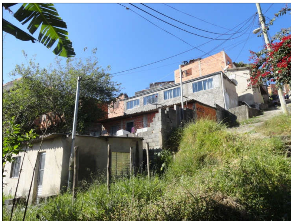
Foto FC-ITA-13-01.04: Vista da ocupação no trecho baixo do setor.
