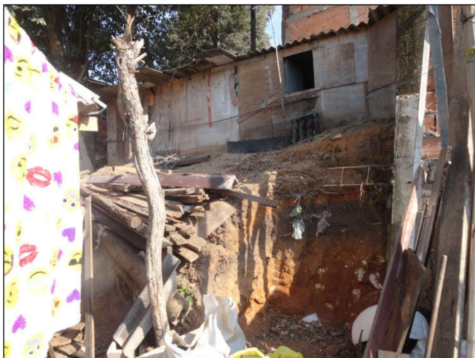
Foto FC-ITA-11-01.04: Vista da ocupação na base e no topo de talude de corte.
