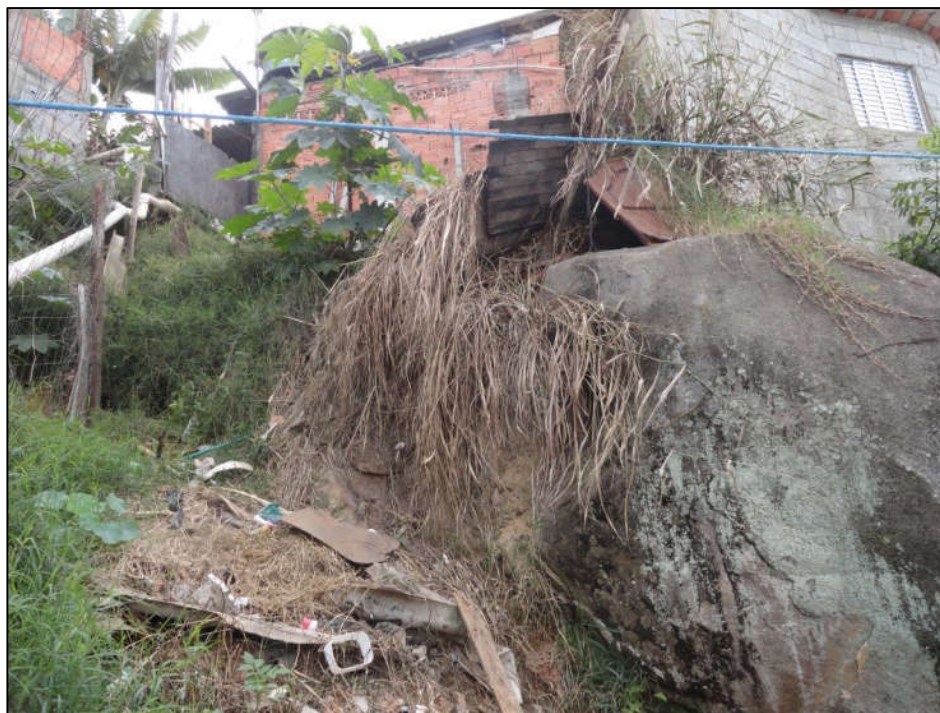
Foto FC-ITA-15-02.01: Bloco de rocha (matação) com moradias no topo. Notar a movimentação de solo.
