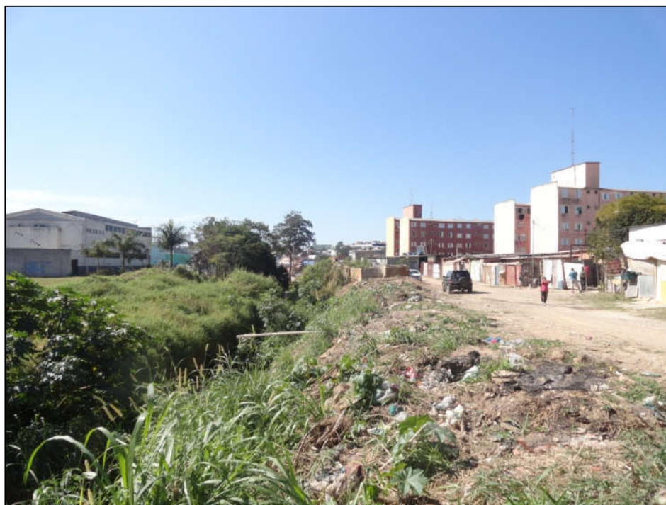
Foto FC-ITA-12-01.02: Trecho mediano da área com as margens do córrego cobertas por vegetação e com lançamento de água servida (observar tubulação no centro da foto).
