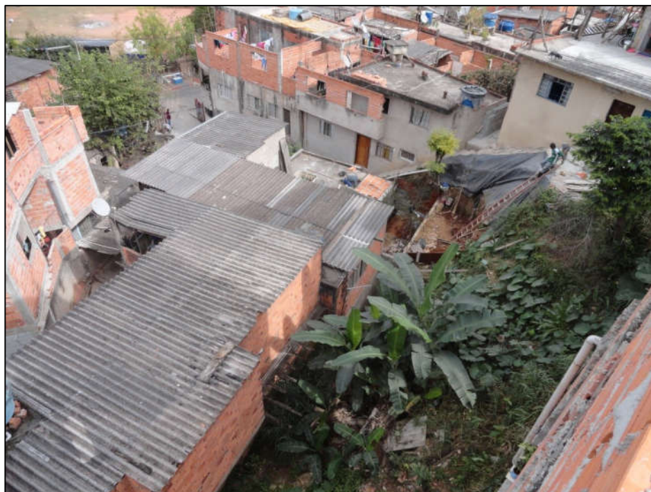
Foto FC-ITA-15-03.04: Vista do setor com moradia ameaçada e o talude de corte com a construção do muro de contenção.
