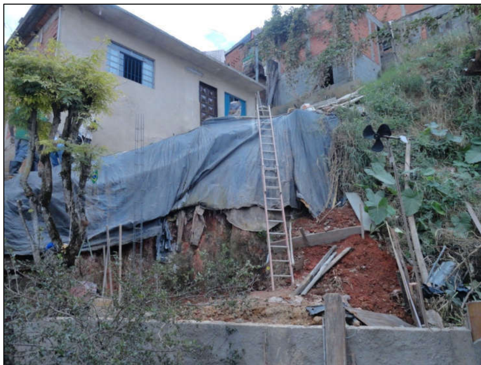
Foto FC-ITA-15-03.01: Vista do talude de corte onde está sendo construído muro de contenção.
