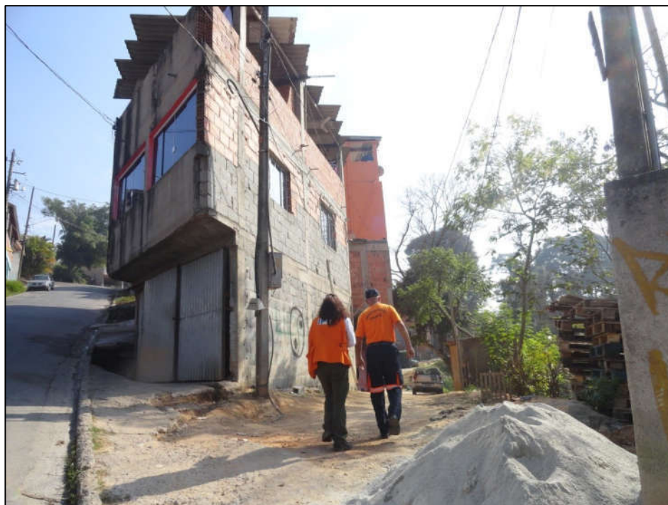
Foto FC-ITA-11-02.04: Vista da entrada no setor com a Rua Dalas à esquerda.
