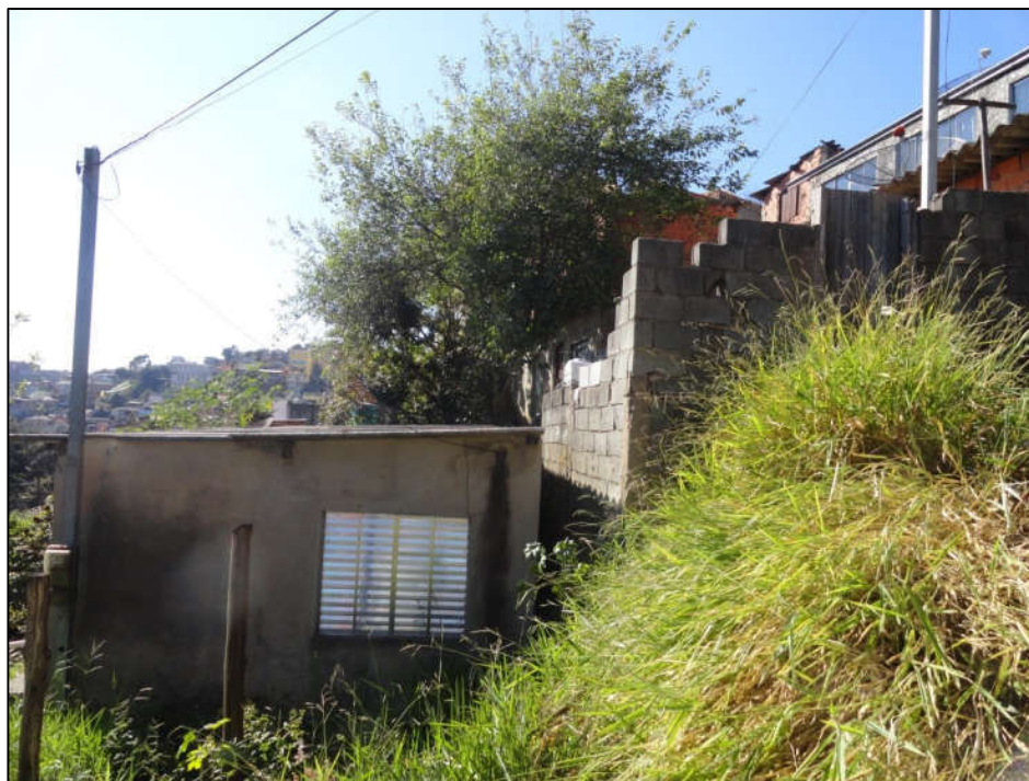
Foto FC-ITA-13-01.03: Aspecto da ocupação com talude de corte com moradias em alvenaria.
