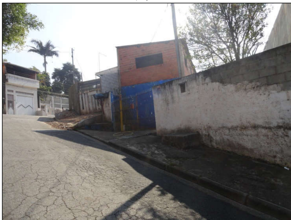
Foto FC-ITA-10-01.02: Vista da ocupação em alvenaria bastante consolidada.
