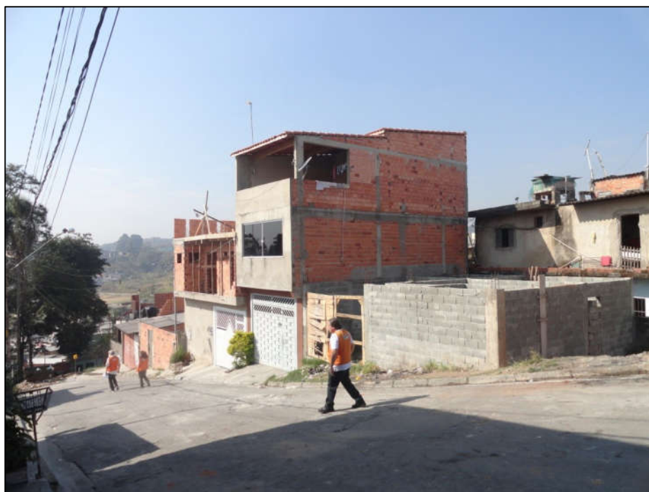
Foto FC-ITA-10-01.04: Vista da ocupação em alvenaria a partir da rua José Celestino dos Santos.
