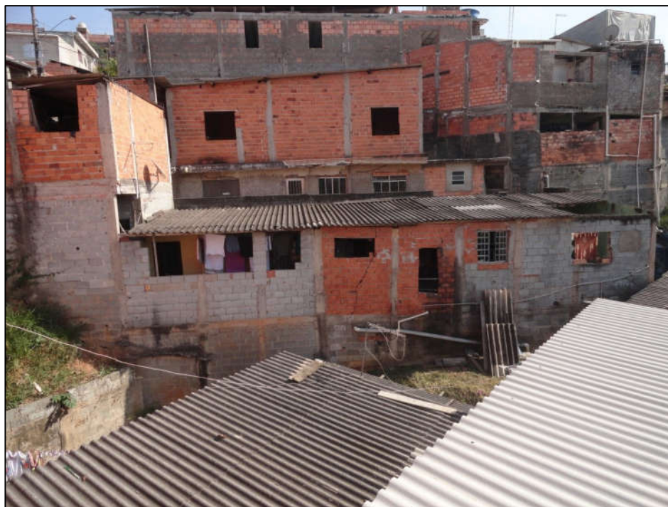
Foto FC-ITA-10-01.01: Vista da ocupação em alvenaria com alta densidade.
