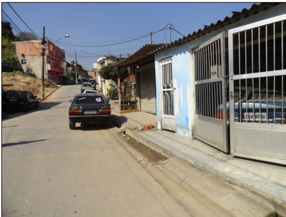
Foto FC-ITA-01-01-01.04: Moradias próximas ao córrego (rua Ferroviária). Notar a alta densidade da ocupação.
