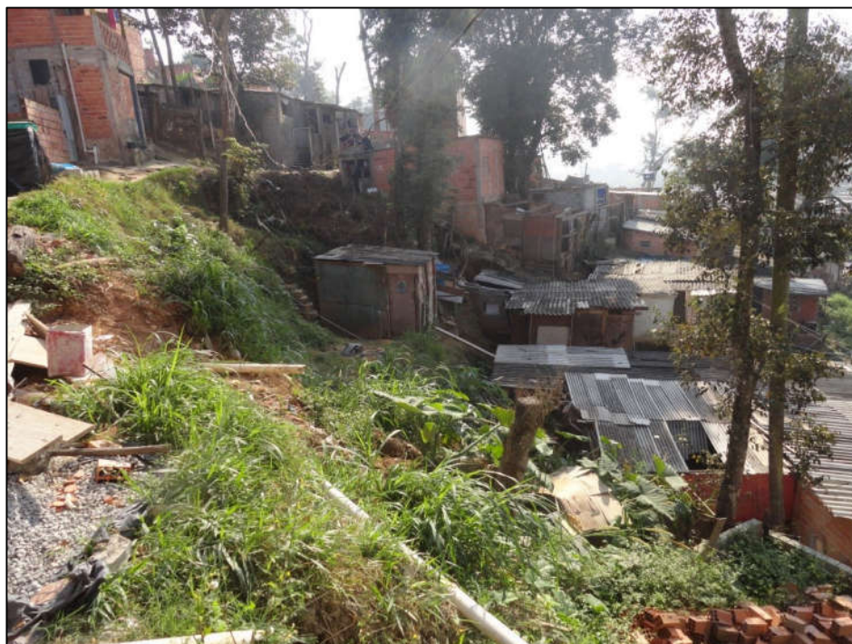
Foto FC-ITA-11-01.02: Vista do setor à direita da foto na base do talude de corte com moradias de madeira.
