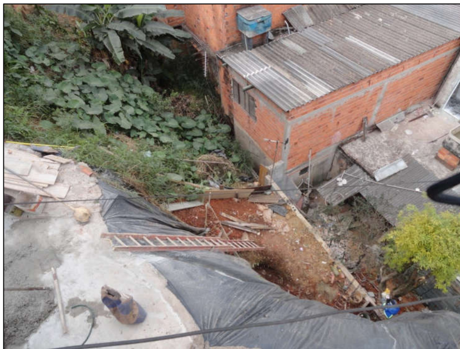
Foto FC-ITA-15-03.03: Detalhe da construção do muro de contenção com a moradia ameaçada na base do talude de corte.
