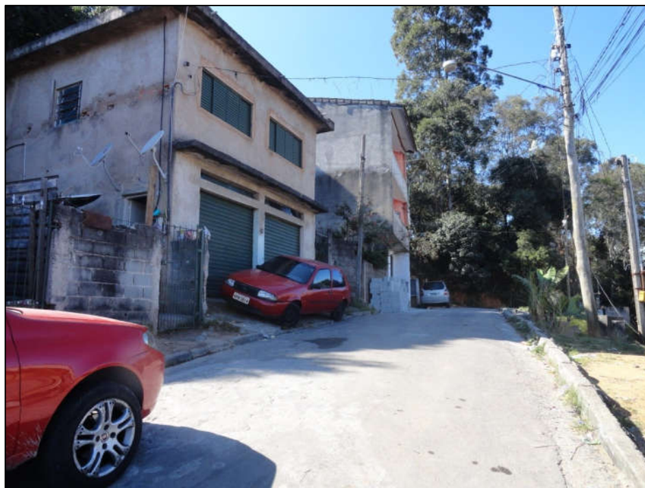
Foto FC-ITA-14-01.07: Vista da rua onde a ocupação à esquerda pertence ao setor.
