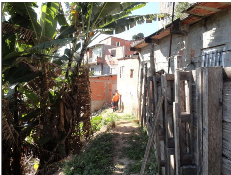
Foto FC-ITA-13-02.01: Trecho superior do setor de alto risco para escorregamentos com as moradias à direita e o talude de corte à esquerda.
