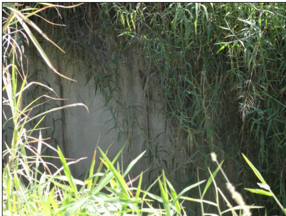
Foto FC-ITA-12-01.04: Vista da parede de concreto do canal do córrego.
