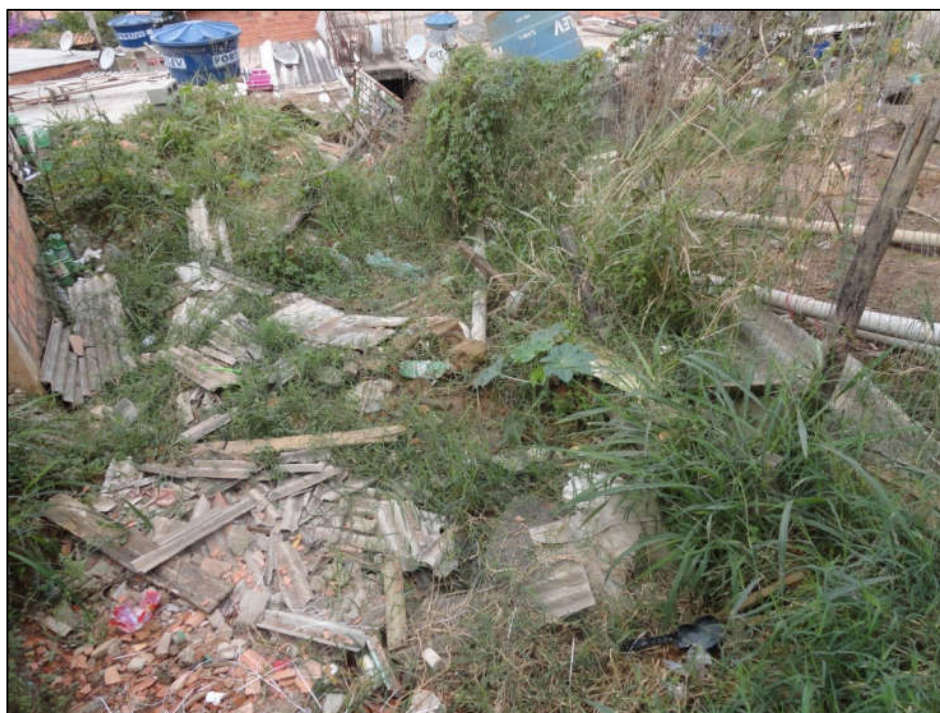
Foto FC-ITA-15-02.04: Vista do depósito de material advindo da movimentação de solo a partir do talude de corte.
