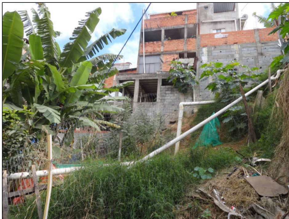
Foto FC-ITA-15-02.03: Aspecto da drenagem de águas servidas com o talude de corte e movimentação de material à direita da foto.
