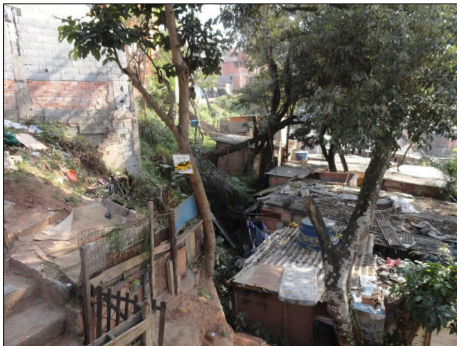
Foto FC-ITA-11-01.01: Vista da ocupação sobre talude de corte. O setor se inicia a partir do talude de corte não incluindo as moradias de madeira à direita da foto.
