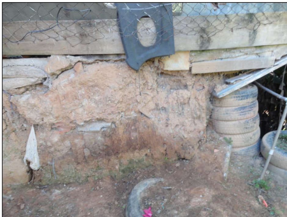
Foto FC-ITA-14-02.03: Aspecto da contenção com pneus e aterro sob moradia.
