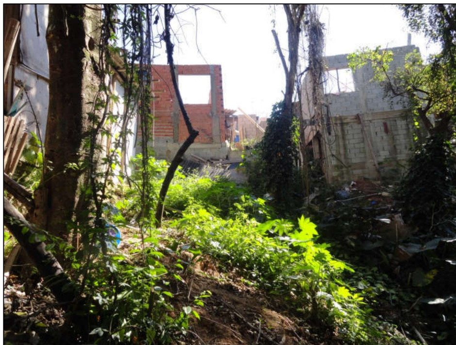
Foto FC-ITA-14-02.05: Vista do setor com moradias em construção sobre aterros.
